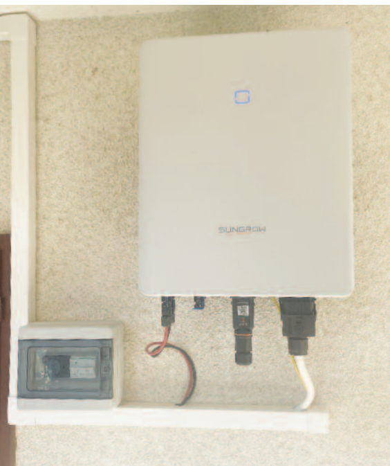
Egy háztartási méretű napelemes rendszer külső falra szerelt invertere
