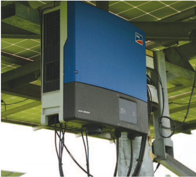
2. kép – A napelemtábla alá felszerelt SMA inverter
