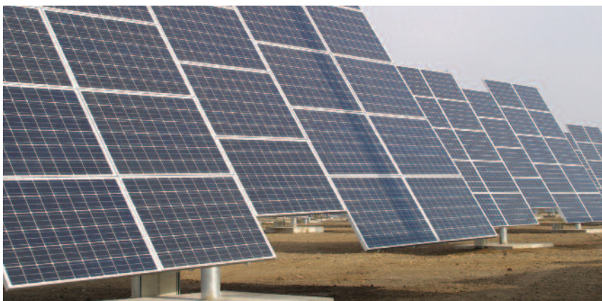
1. kép – Napkövető napelempaneltáblák a naperóműben
