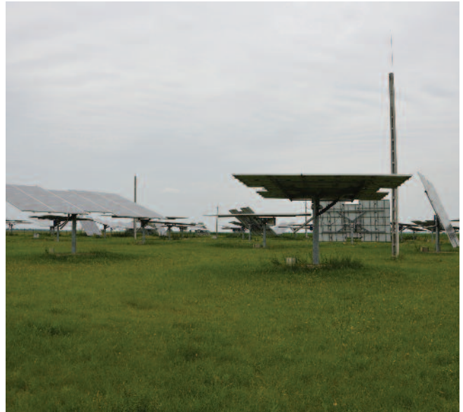
3. kép – Felújításra várnak a napelemek forgatótáblái
