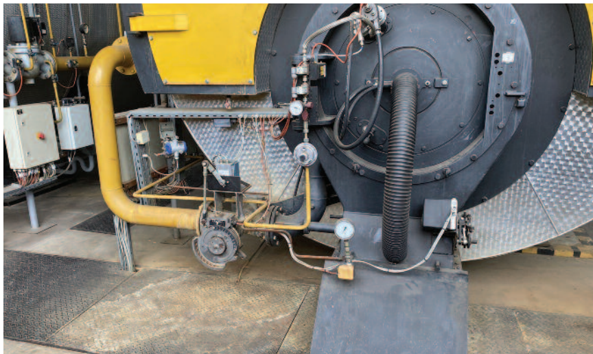
3. kép – Nagy teljesítményű kazán légcsatornás égésilevegő-ellátással
