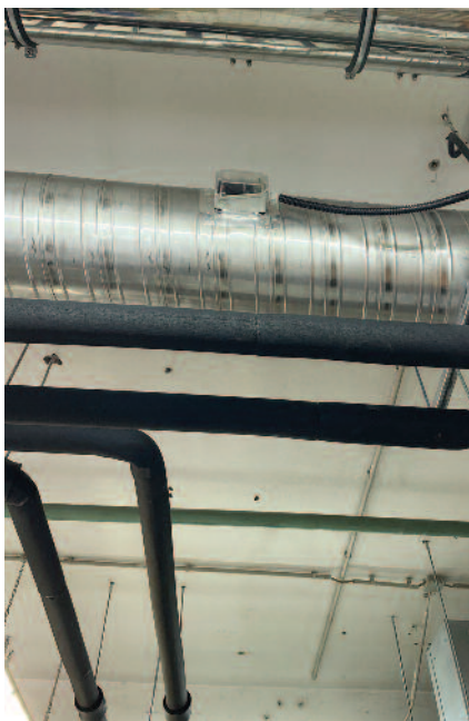
2. kép – Áramlásérzékelő, égcsatornába szerelve
